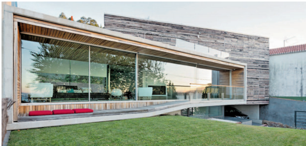
Cristal, madera de batea reciclada y hormigón componen la fachada de la vivienda de A Ribeiriña. FOTOS: ADRIÁN VÁZQUEZ
